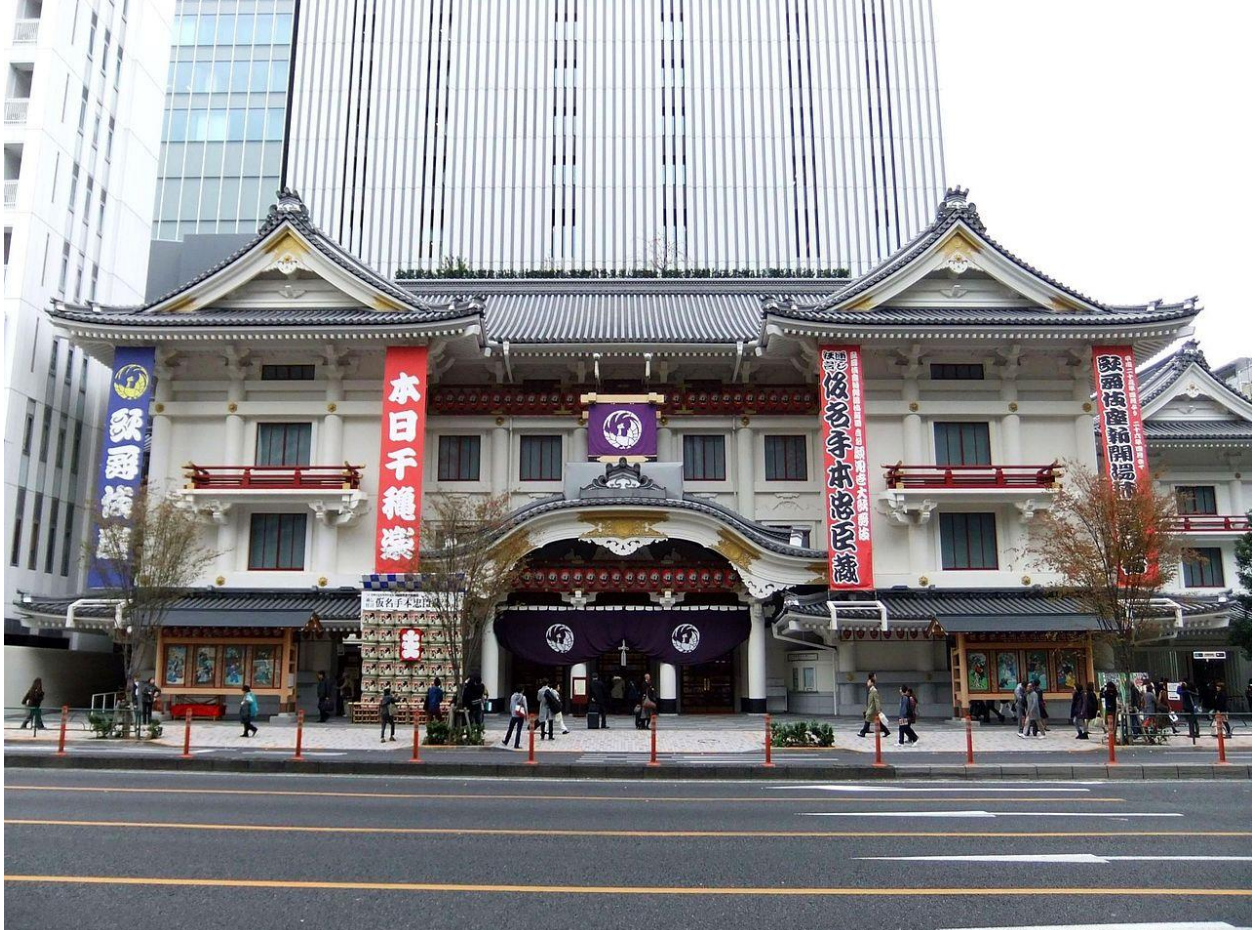
The Kabuki-zatheater in Tokyo
